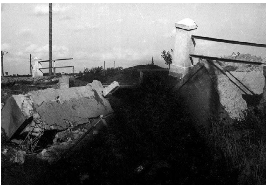
Zničený most přes řeku Blatu
