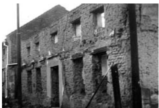
Dva snímky z demolice původního domu č. 1
